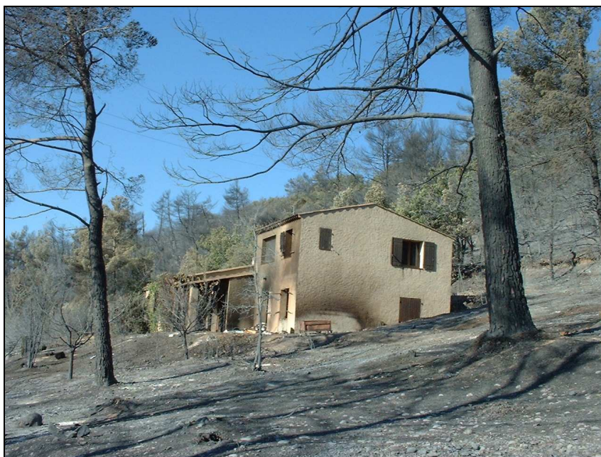
Corbières, habitation endommagée suite à l'incendie du 24/07/2002, photo : P. Richard, ONF.
